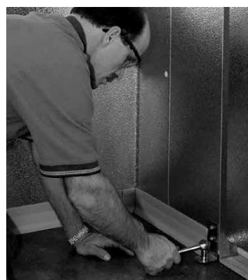
Fije la riostra de sostén con el sujetador provisto
