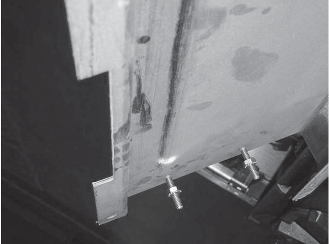
Rail avec goujons pour support d'extrémité de rail.
